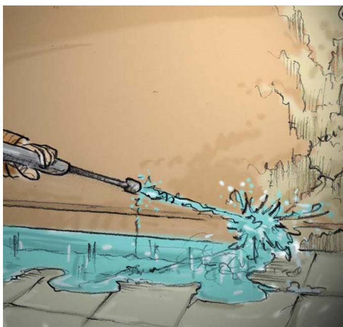
fig. 7: Pulizia preliminare della muratura
